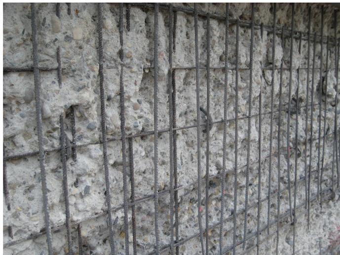
*Bild 4: Vorbereitete Betonoberfläche mit freigelegter Bewehrung – mechanische Verankerung des Spritzbetons sichergestellt*
